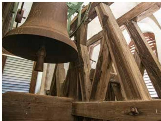
Abb.10: St. Georgen am Gasenbach, Glockenstuhl-Konstruktion
