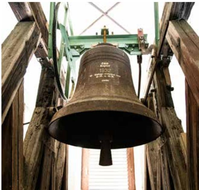
Abb.12: St. Georgen am Gasenbach, Glockenstube mit Glocke, Stahl – 700 kg, Gießler Böhler, 1932
