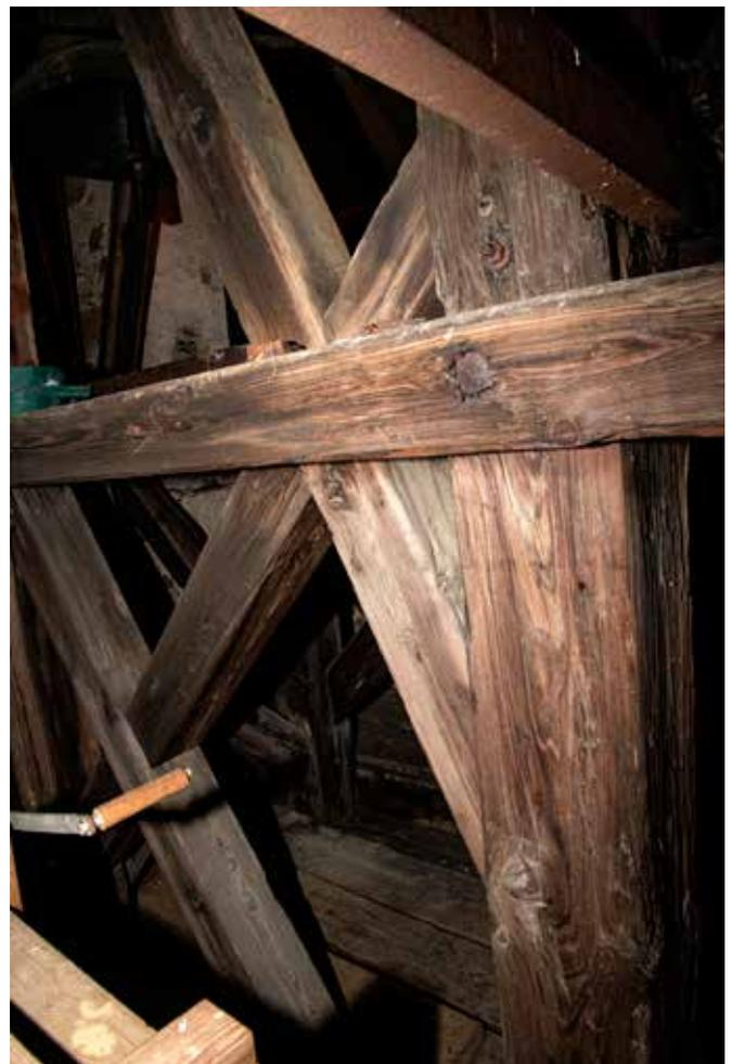
Abb.11 Glockenstuhl – Detail Säule, Riegel, Strebe
