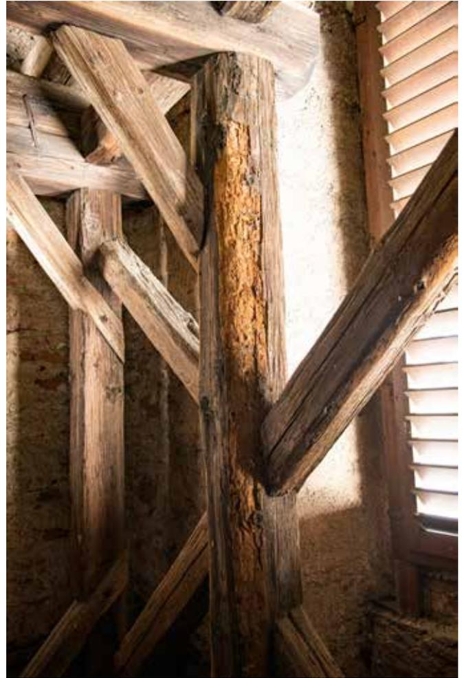
Abb.12 – Glockenstuhl – Detail der Holzfachwerkskonstruktion
