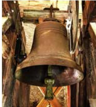
Abb 18: Glocke in b' mit 383 kg (Böhler)
