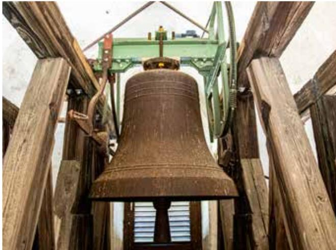
Abb.11: St. Georgen am Gasenbach, Glockenstuhl mit Glocke, Stahljoch und Seilrad
